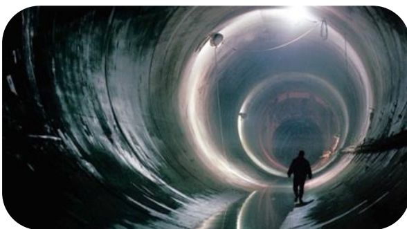
DRENAJES PROFUNDOS Y ACUEDUCTOS
