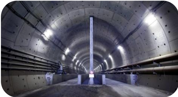
TÚNELES DE HIDROELÉCTRICAS
